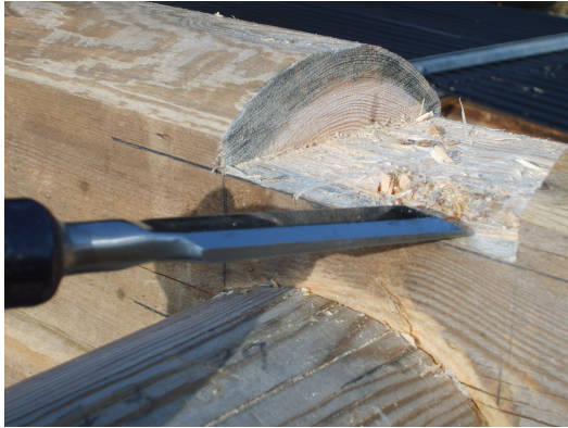
13. Använd stämjärn eller yxa för att ta bort överflödigt material och göra tröskeln plan.
