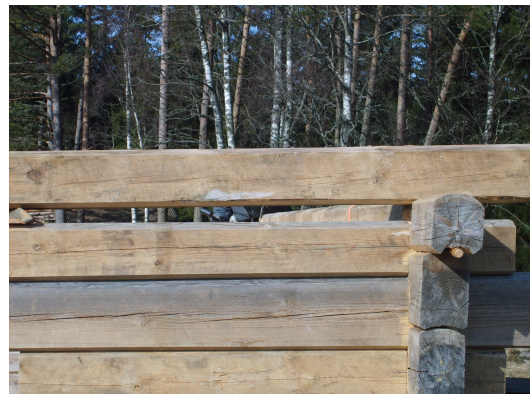
18. Placera nästa timmer i knuten. Tillse att det ligger parallellt med timret under.
