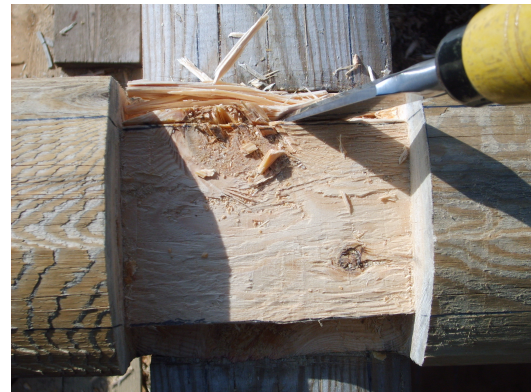
16,17. Använd stämjärnet för att arbeta fram haket.
