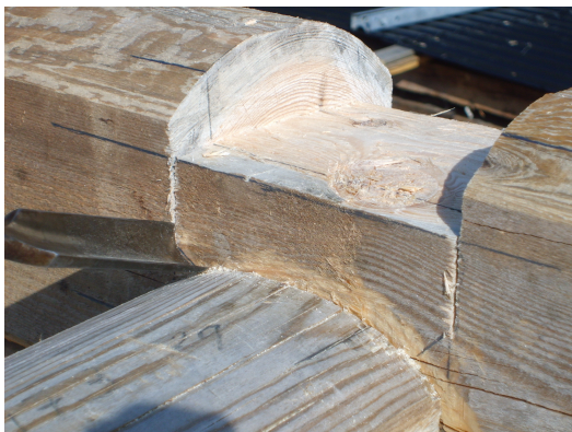
15. Hakets bredd markeras, förläng strecken uppåt och utåt sidorna. Ett rundat stämjärn är lämpligt till nedre delen (skall passa konturen på nästa timmer).
