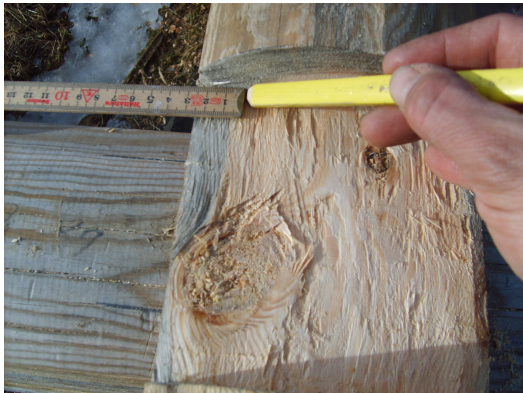
14. En dubbelhaksknut har ett hak på insidan och ett på utsidan. Med tumstock mäter du hakets djup, ofta 2,5 cm (1 tum).
