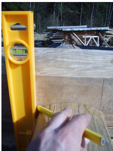
7. För över bredden till den blivande knuten, båda linjerna som utgör knutens bredd skall vara i lod.
