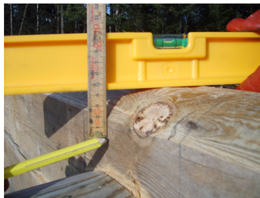
10. Höjden på den blivande knutens tröskel mäts från passets underkant och nedåt, i detta fall 4,5 cm. Gör denna mätning både på knutens utsida och insida, på så vis erhålles en vågrät tröskel.
