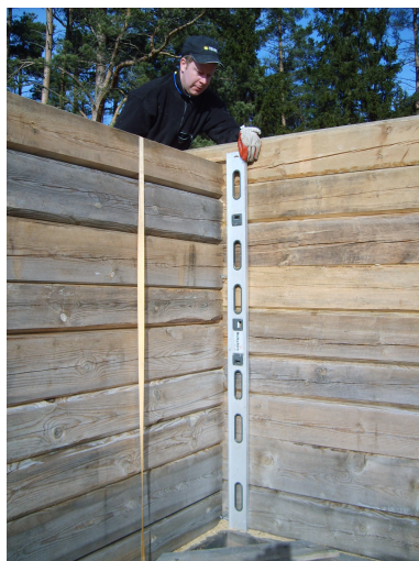
4. Identiskt placerade spikar som referenspunkter i varje hörn underlättar mätning av konstruktionens höjd och kan också, som i detta fallet, utnyttjas för att få knutkedjan lodrät.
