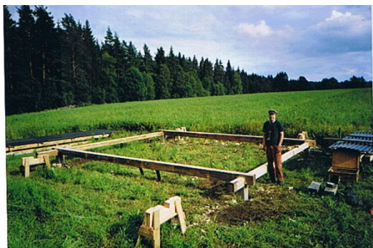
1. Syllvarvet utlagt, mät diagonalerna.
