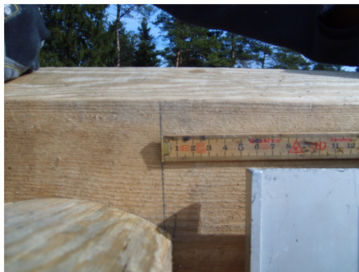
5. Första åtgärden för att konstruera knuten är att mäta fram innermättet, här 5 cm från långpassets kant.
