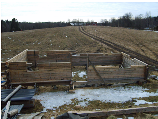
2. Ett halvår senare har bygget kommit ungefär till fönsternivå. Täck över konstruktionen mellan arbetsdagarna.
