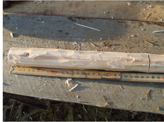
41. Såga den i rätt längd. Eftersom hålet var 28 cm görs dubben 27 cm för att ge sjunkmån.
