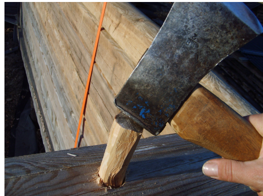
42. Slå ner dubben. Den ska gå trögt men inte kräva kraftigt våld för att passa.
