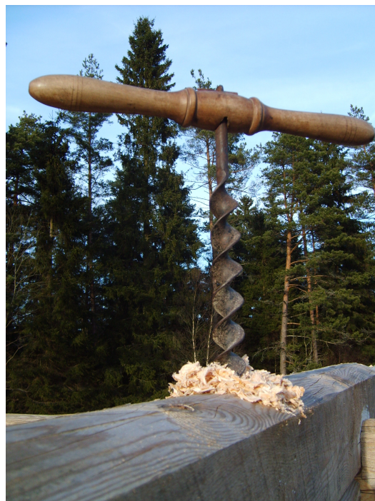
37. Nu kan timret fixeras med en dubb.(Om byggnaden skall stå kvar på denna plats kan du nu lägga på isolering mellan stockarna och i knuten, vanligast är husmossa eller väggmossa. Färsk/fuktig och ren från kvistar och kottar)
