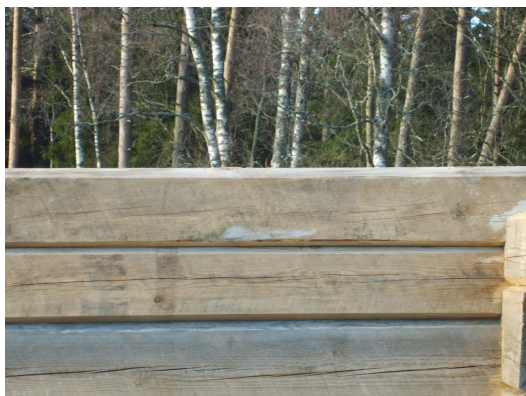
34. Nästa steg är att lägga stocken på plats...
