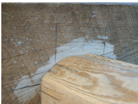
36. ...och i knuten. Dessutom kontrollerar man att avståndet mellan höjdstrecken är c:a 5 mm, därmed är det lite sjunkmåå över tröskeln.
