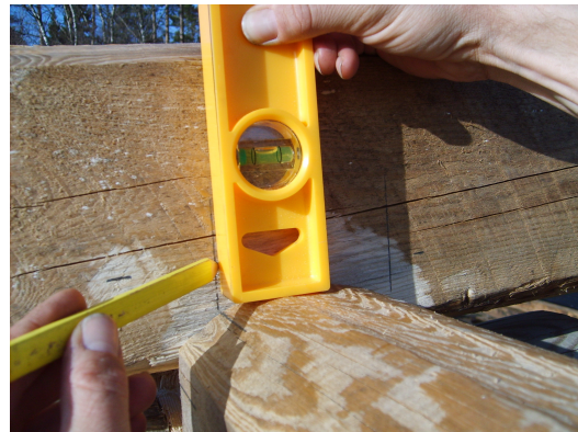
22. Använd linjerna för att markera tröskelnns bredd, med passet som utgångspunkt för du över detta mått till överstocken.
