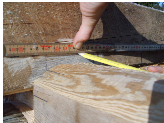
23. Förbind markeringarna som visar höjden, eftersom dessa är i våg behöver du inte använda vattenpass.
