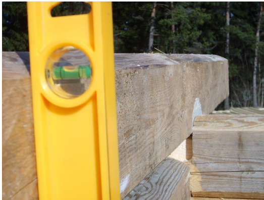
20. Använd pass och ögonmått för att tillse att stockens sida är lodrät. Ibland är timret vridet, man kompromissar då genom att tillåta lika mycket avvikelse i varje ände/knut.
