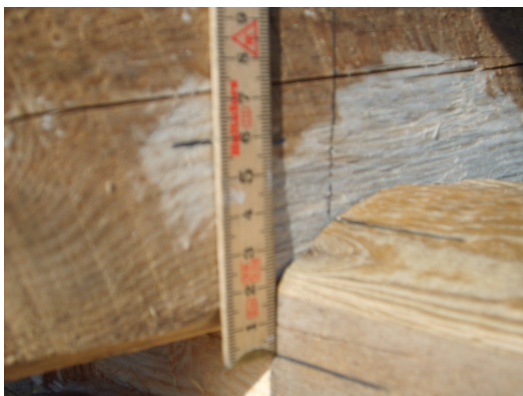
21. Nu ska du göra ett urtag i övre stocken. För att få det korrekt använder du dig av linjerna som visar höjd och bredd på underliggande tröskel. Eftersom övre timret nu ligger på tröskeln kan du mäta från denna markering (totalt 4 mätpunkter). I detta fallet, med fräst långdrag, har jag kontrollerat att stocken
