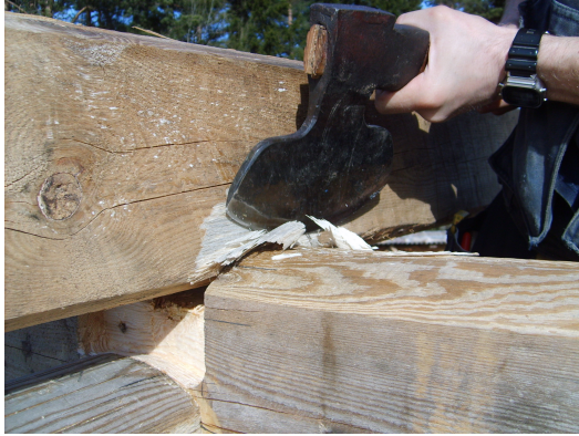
19. Knuten gjordes avsiktligt något trång, använd skrädyxan för att få den att passa exakt och lägga sig på tröskeln.
