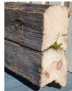
Långdrag, mossor som isolering
